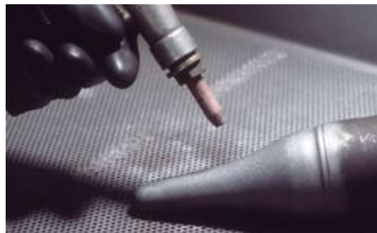
Figura 15 jateamento para a limpeza da superfície
